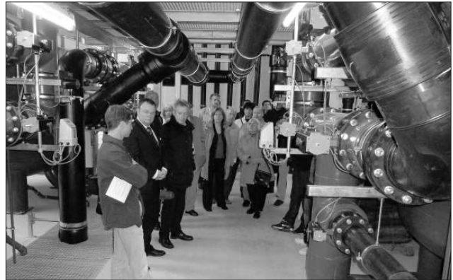
Die komplizierte und beeindruckende wassertechnische Anlage zur Aufbereitung, Reinigung und Erwärmung des Teninger Schwimmbades erklärte einer interessierten Besucherzahl der planende Ingenieur Thomas Senrich.
